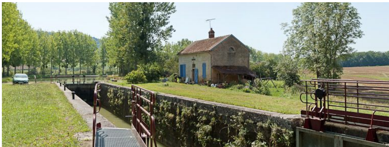
Vue d'ensemble du site d'écluse.
