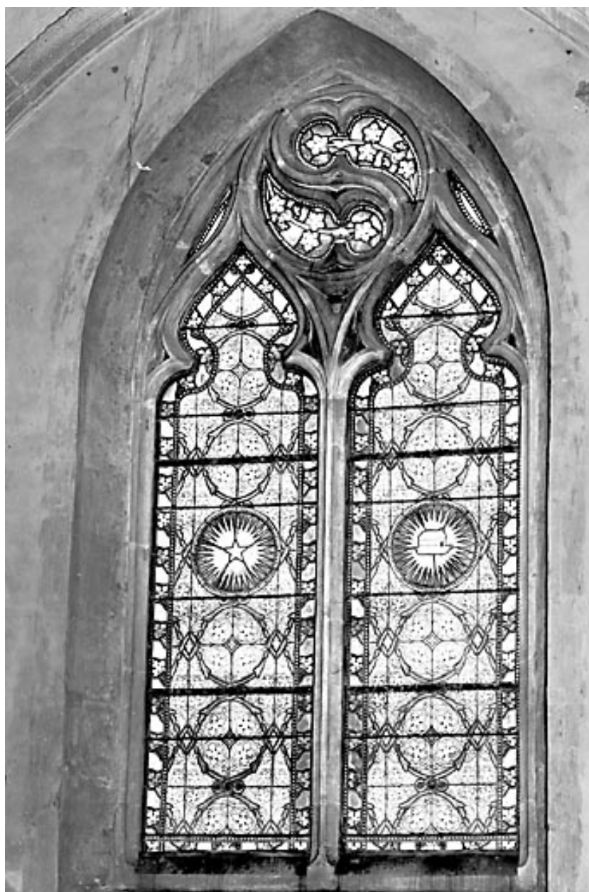
Baie n° 4 : vue générale.
