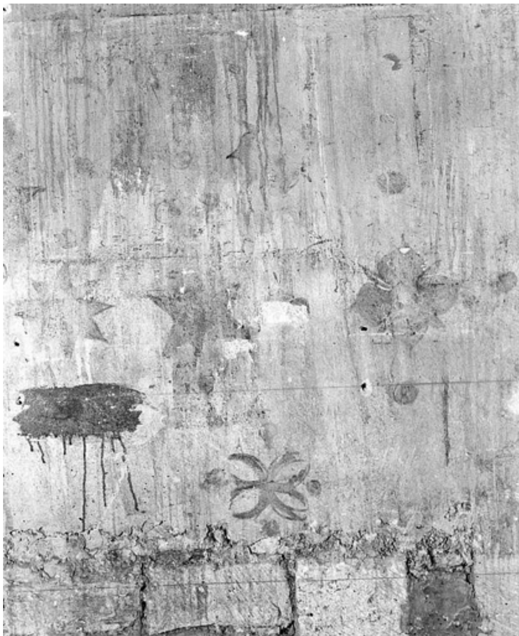
Choeur, mur sud : traces de décor.
