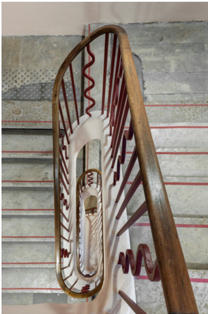
Escalier côté jardin : vue plongeante.
