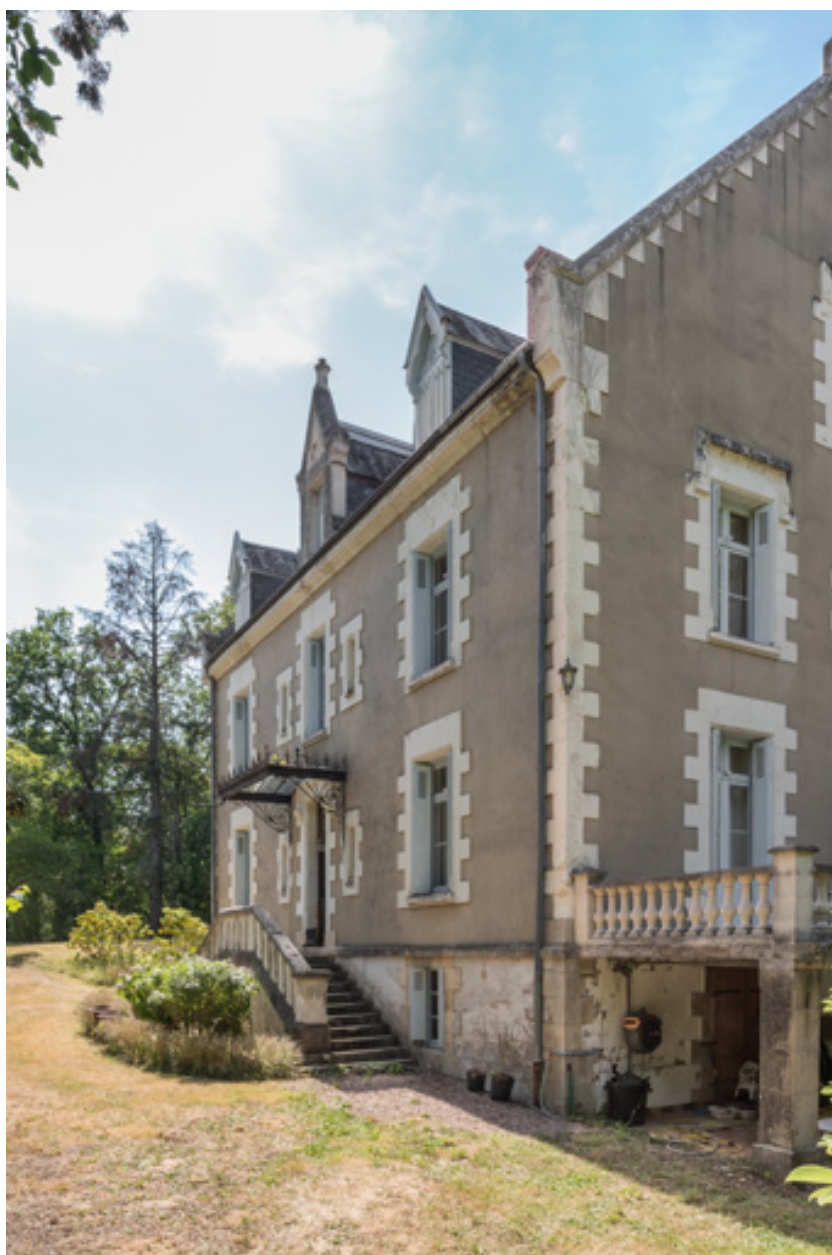
Façade sud-est, vue depuis l'est.
