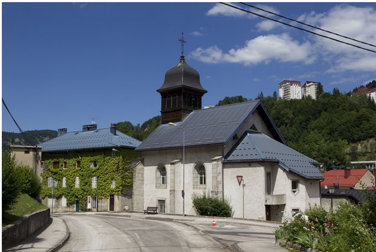
Façade latérale droite.
