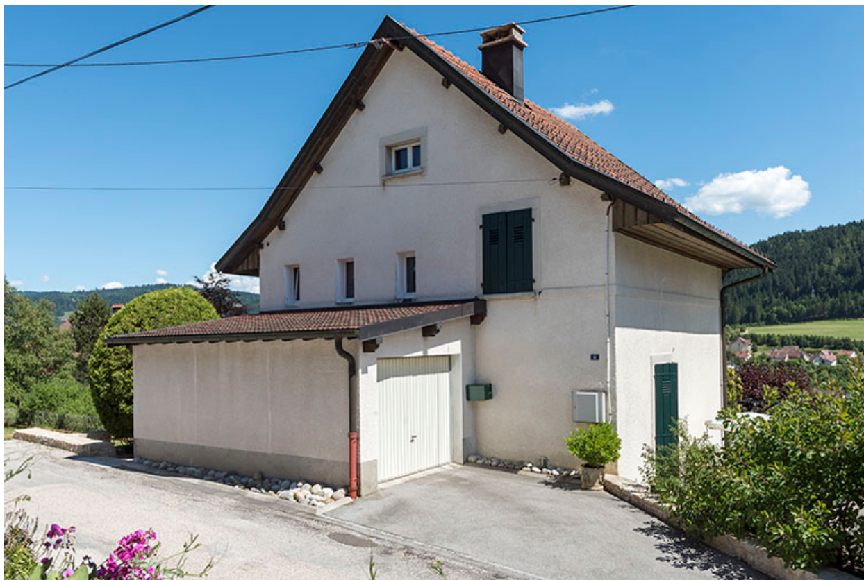
Façades antérieure et latérale droite.
