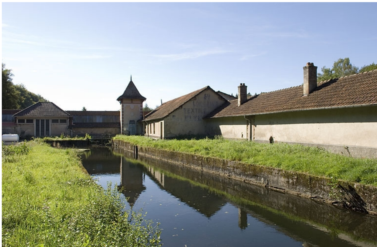
Ateliers et bief d'amenée.
