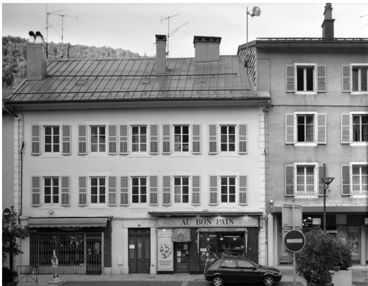
Vue d'ensemble rue de la République.
