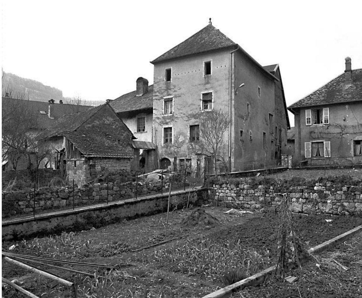
Maison situé rue de la Croix de Sompré.
