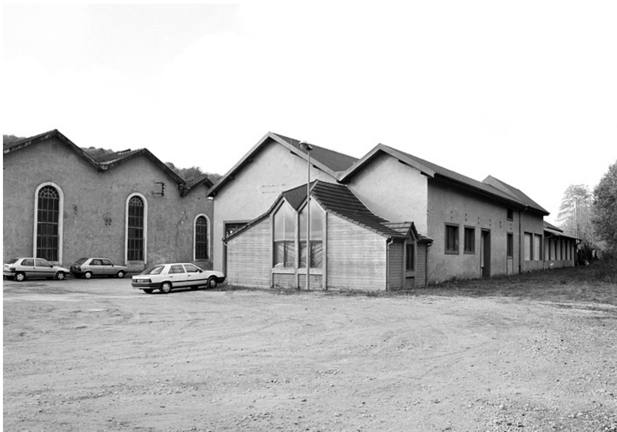
Ateliers de fabrication depuis le sud-est.
