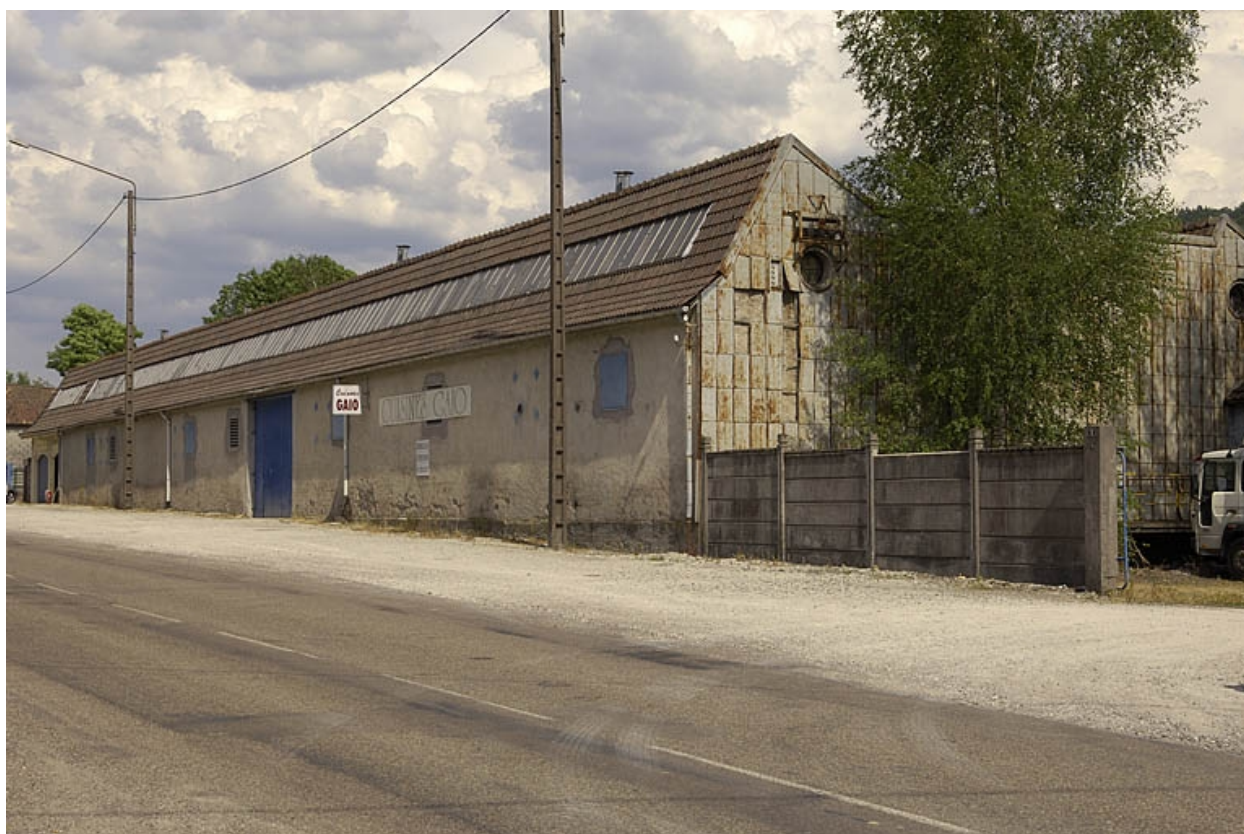
Travées nord de l'atelier de fabrication (tissage).
