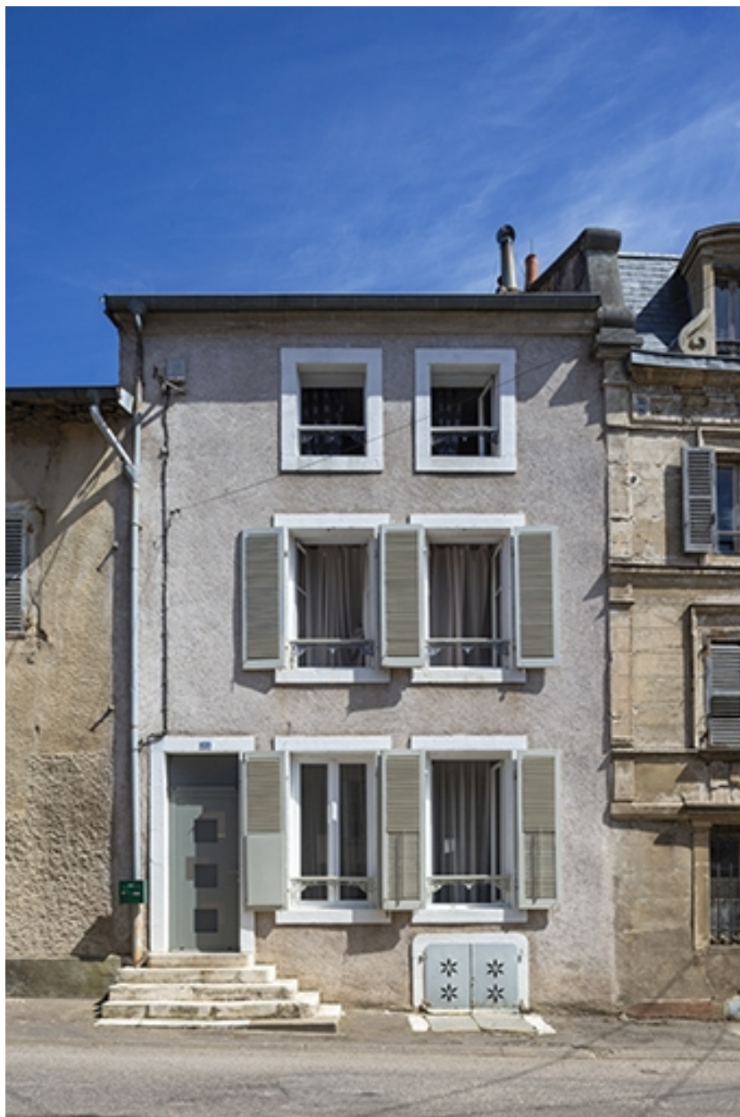
Rue Thiers, façade de la maison n° 22.
