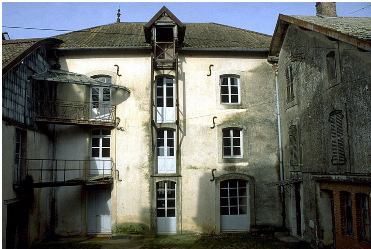
Façade antérieure de l'atelier de fabrication.
