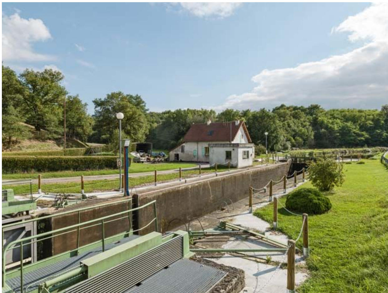
Vue d'ensemble du site d'écluse.
