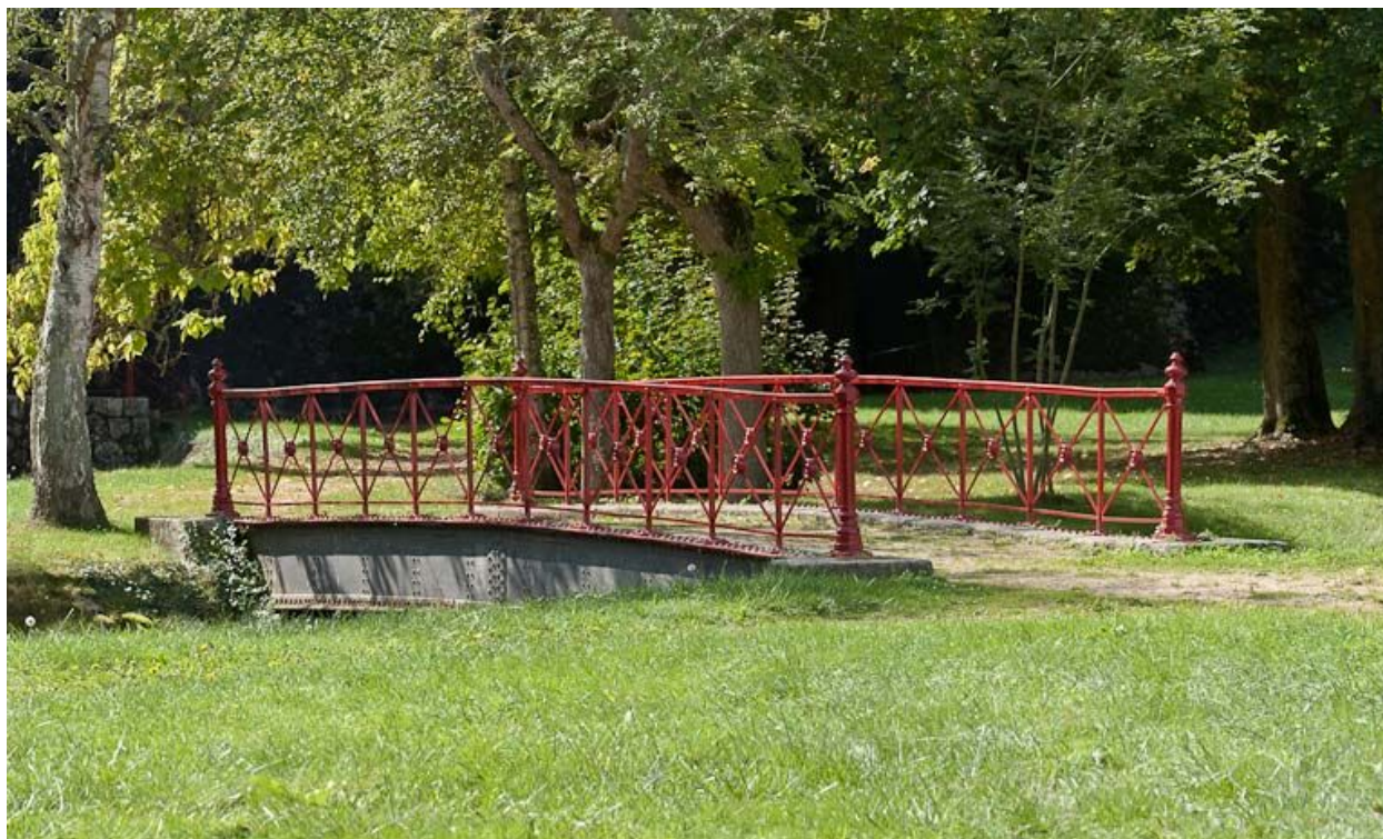
Vue d'un pont sur rigole.
