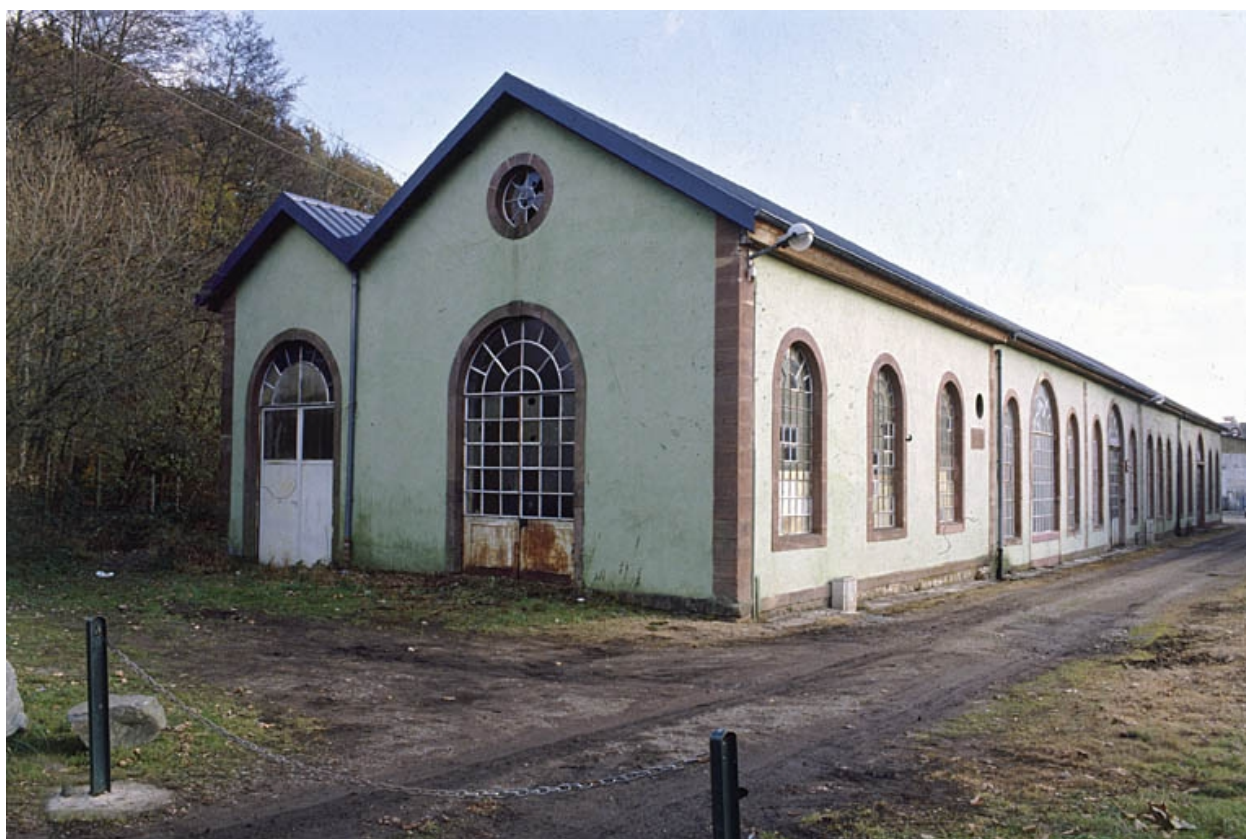
Salle des machines depuis le nord.
