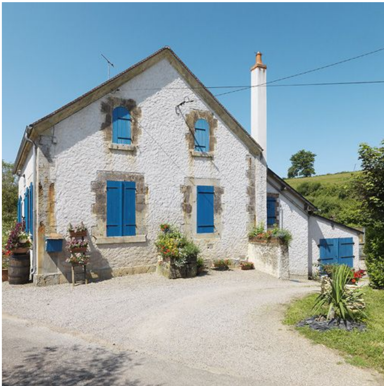
Façade latérale de la maison éclésièr.
