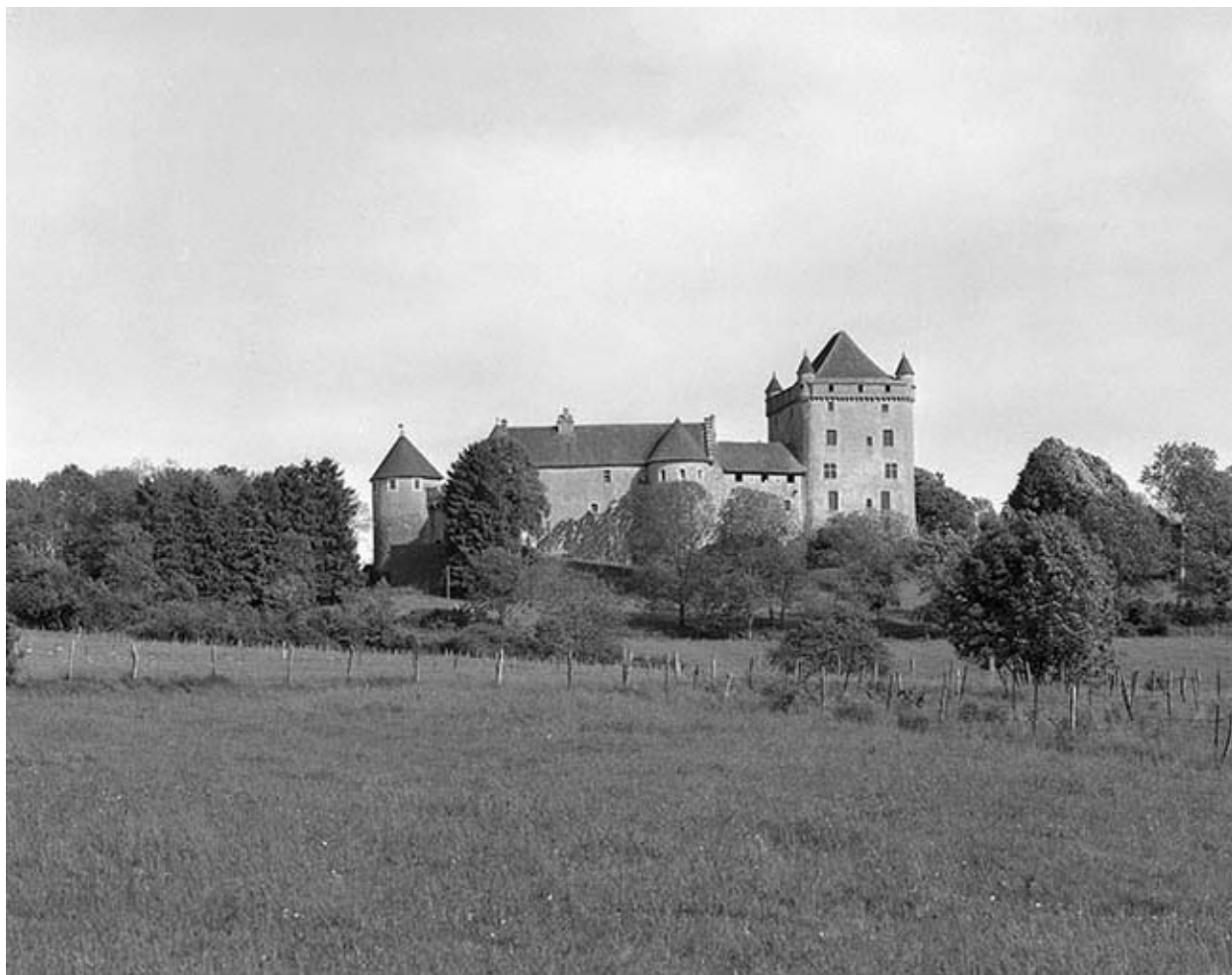
Façade ouest : vue éloignée.
