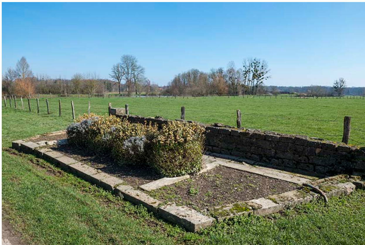
Fontaine, rue du Bac à Port d'Atelier.
