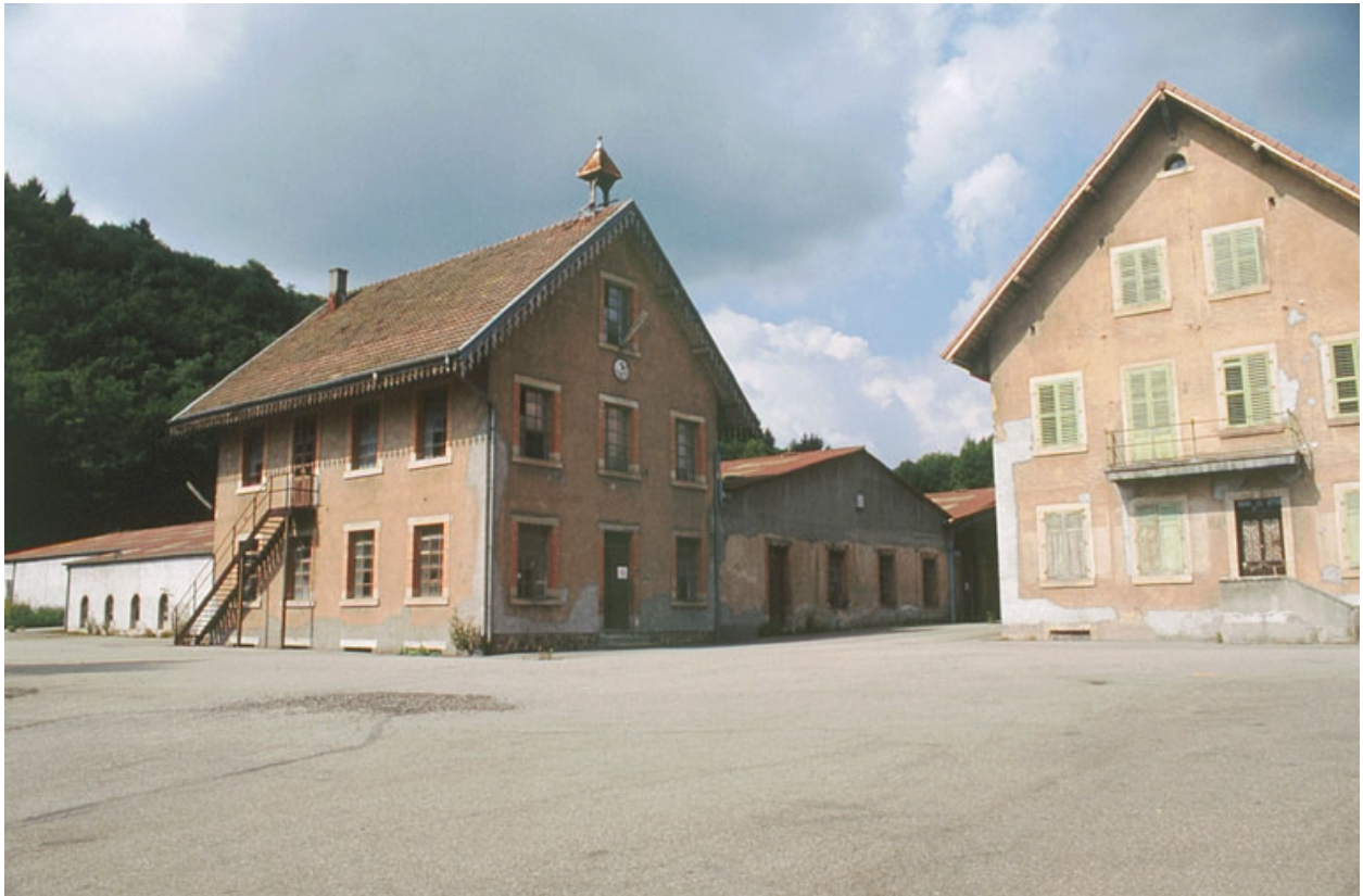
Bâtiments du tissage depuis le sud-est.
