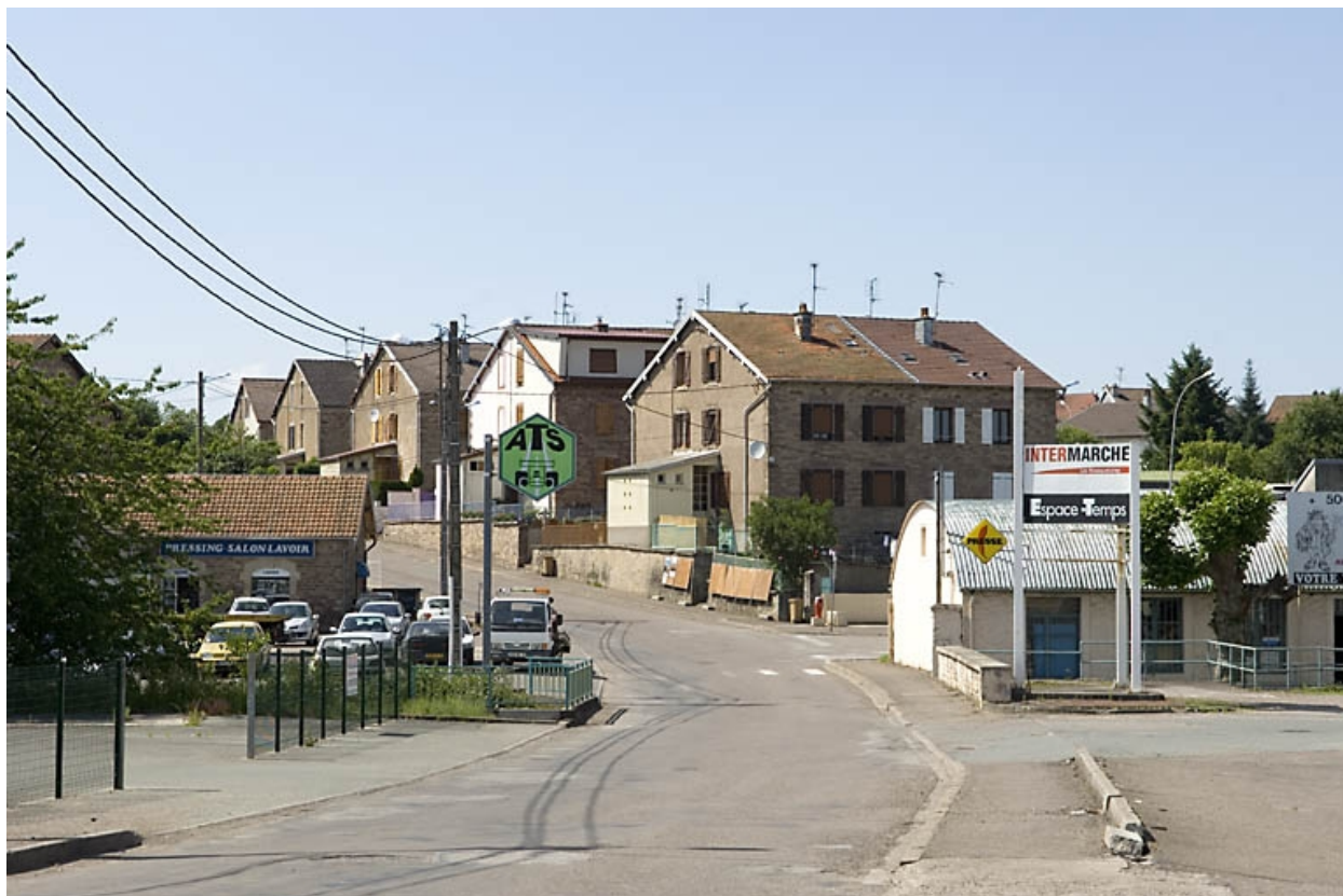
Vue d'ensemble de la cité ouvrière.
