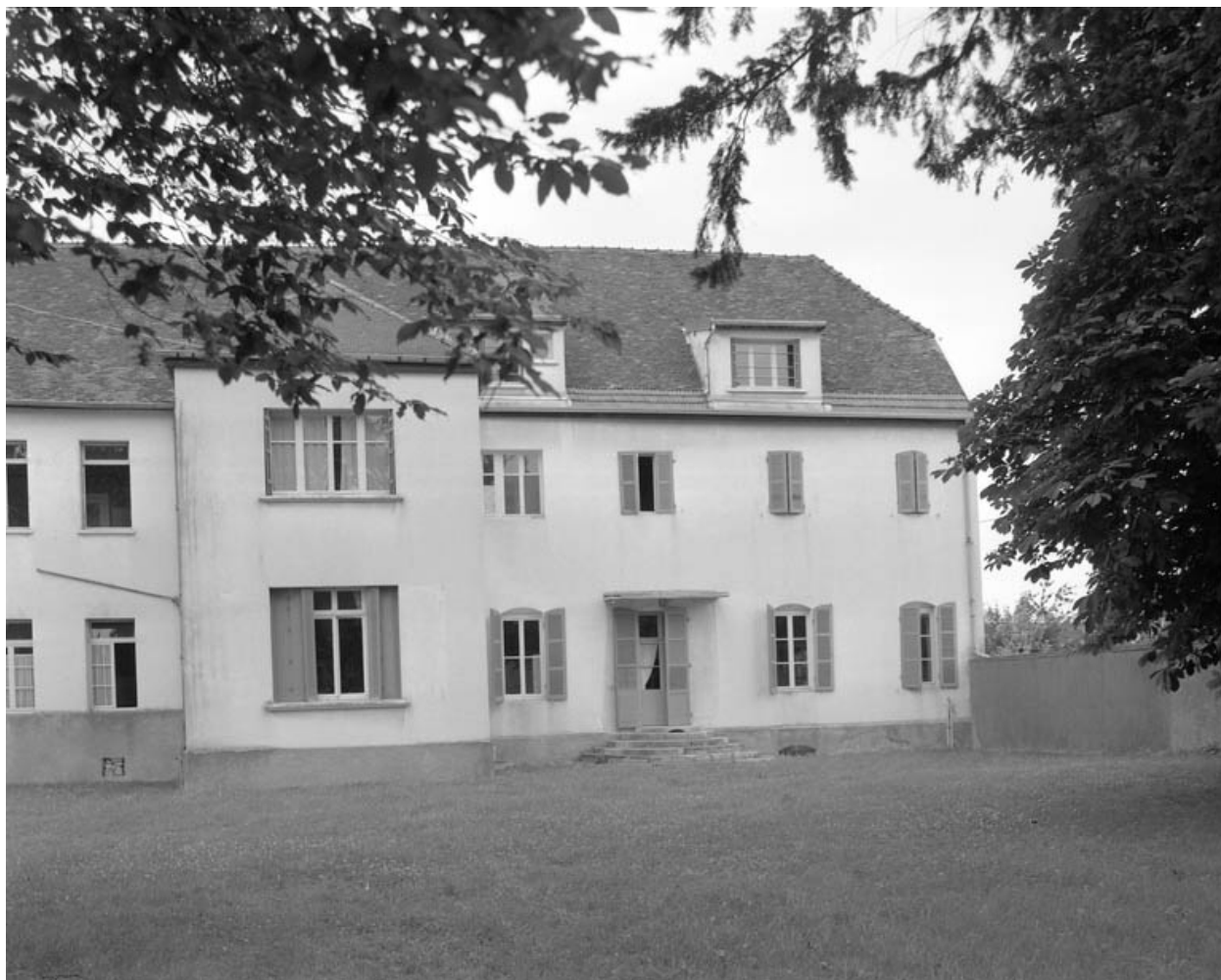
Façade postérieure du bâtiment principal : partie droite.
