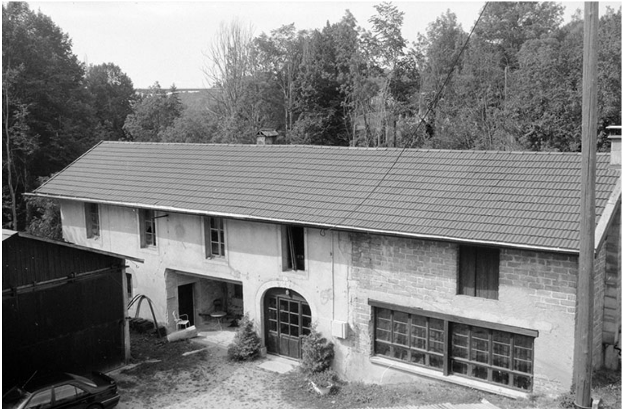
Façade antérieure des ateliers de fabrication.
