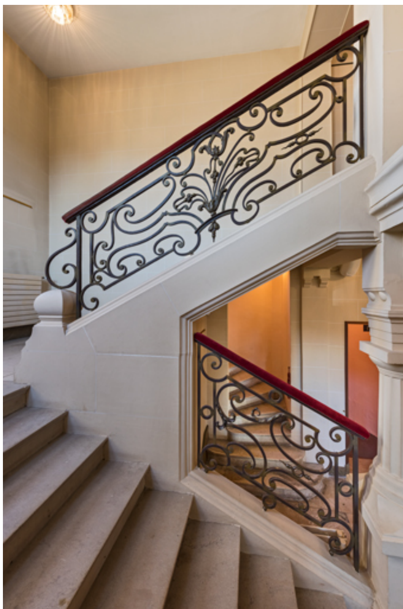
Vestibule : rampes de l'escalier principal.
