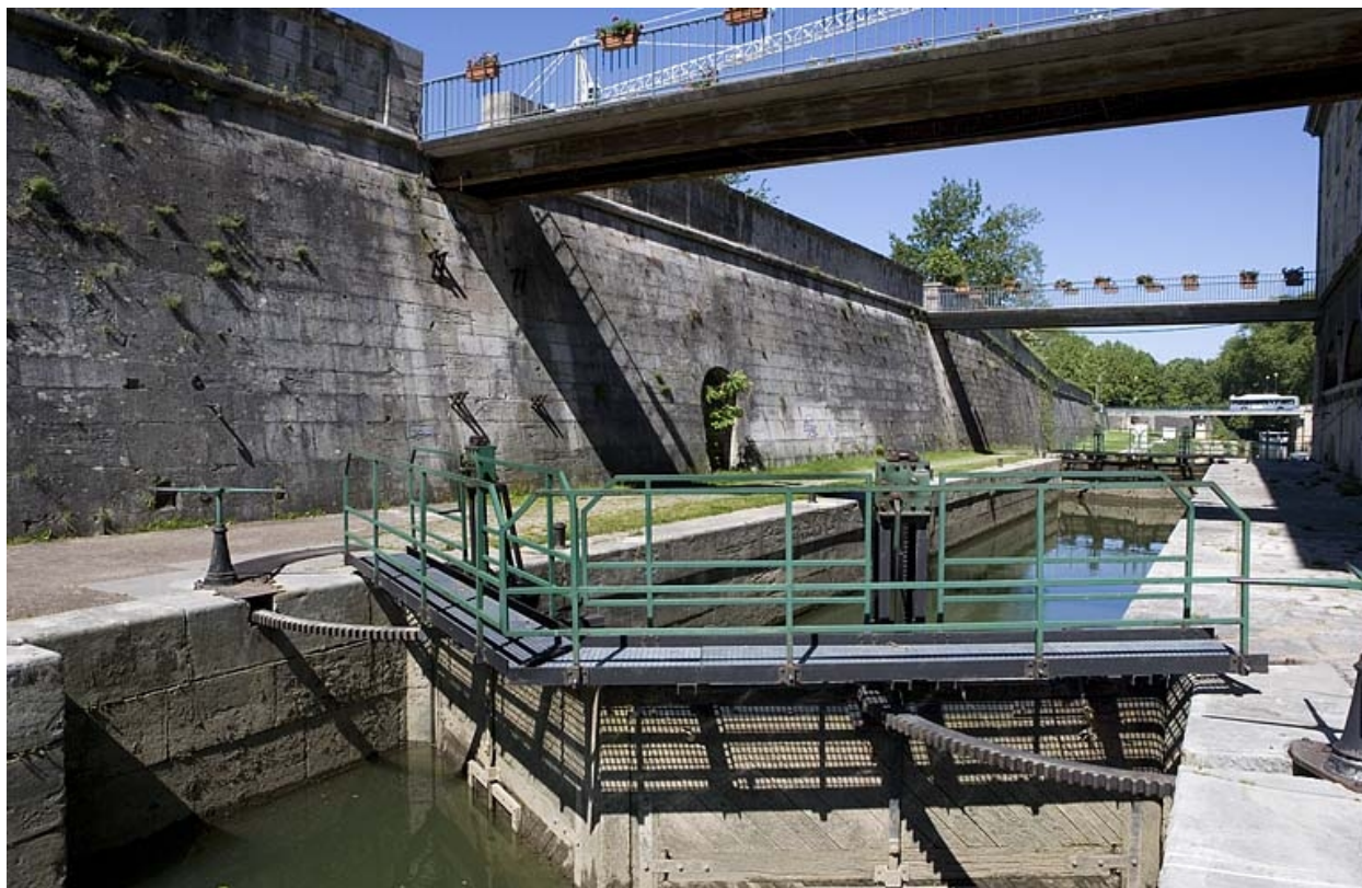
Vue d'ensemble rapprochée depuis l'amont, côté droit.
