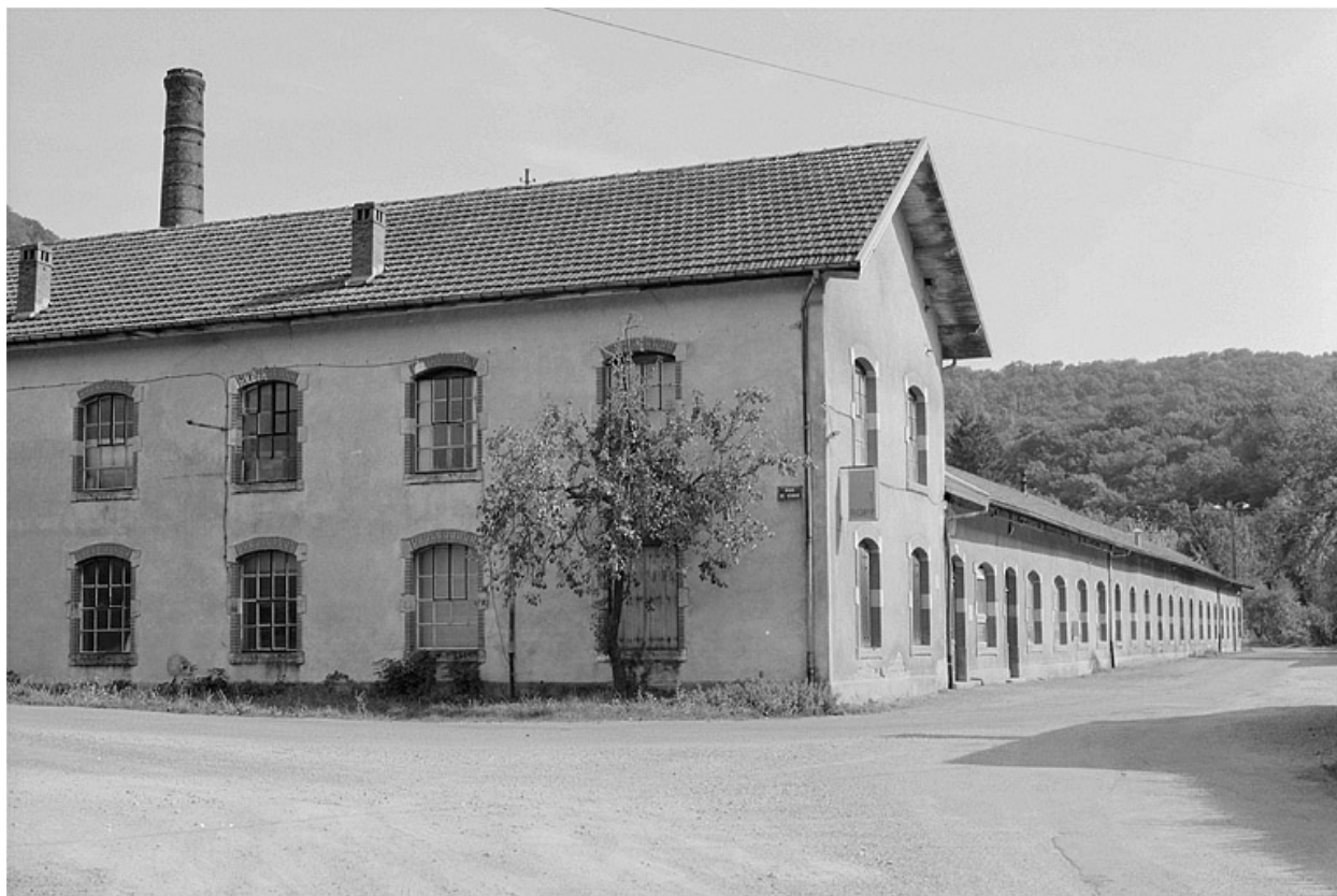
Façade antérieure depuis l'ouest.
