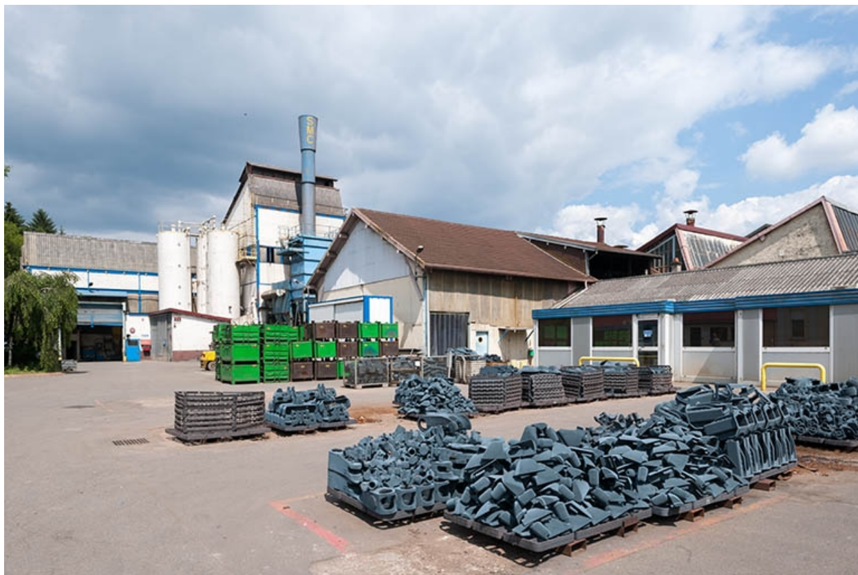
Vue de la cour depuis le sud-ouest.
