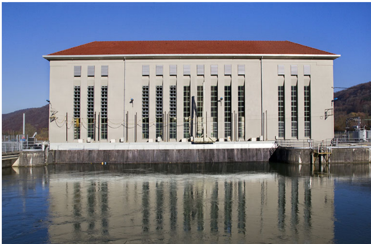
Centrale hydroélectrique de Dampjoux, Noirefontaine.
