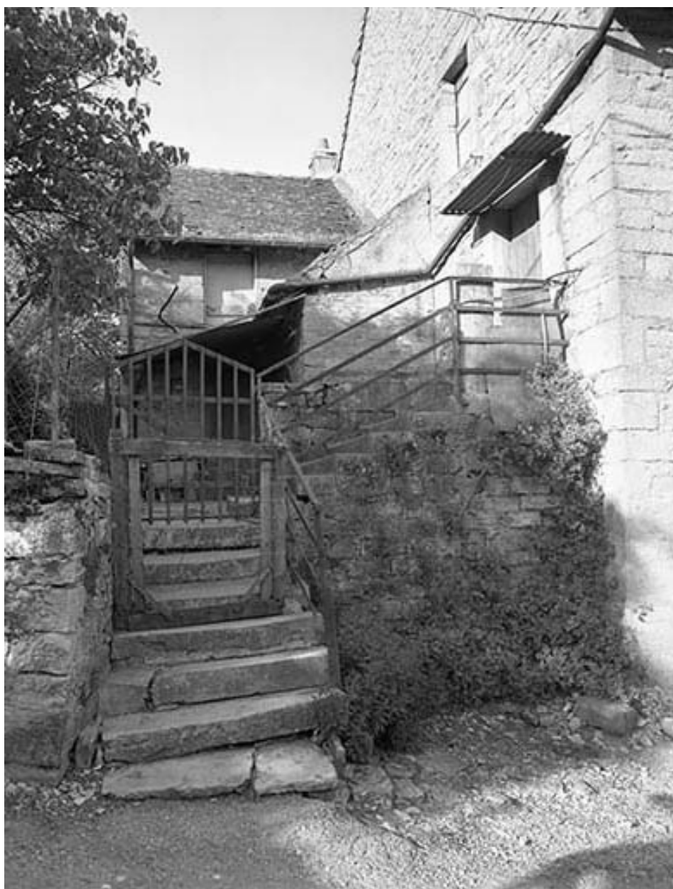
L'escalier d'accès à l'habitation.
