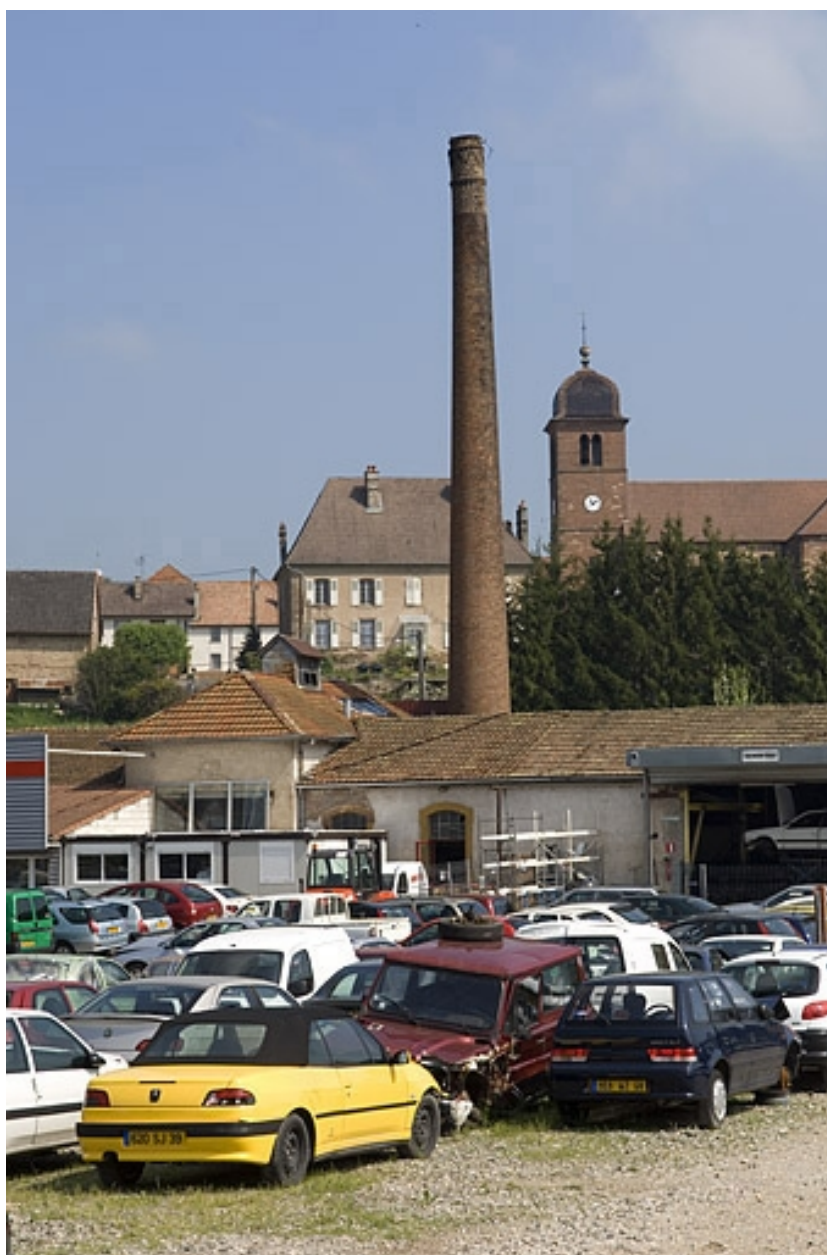
La chaufferie et la cheminée.
