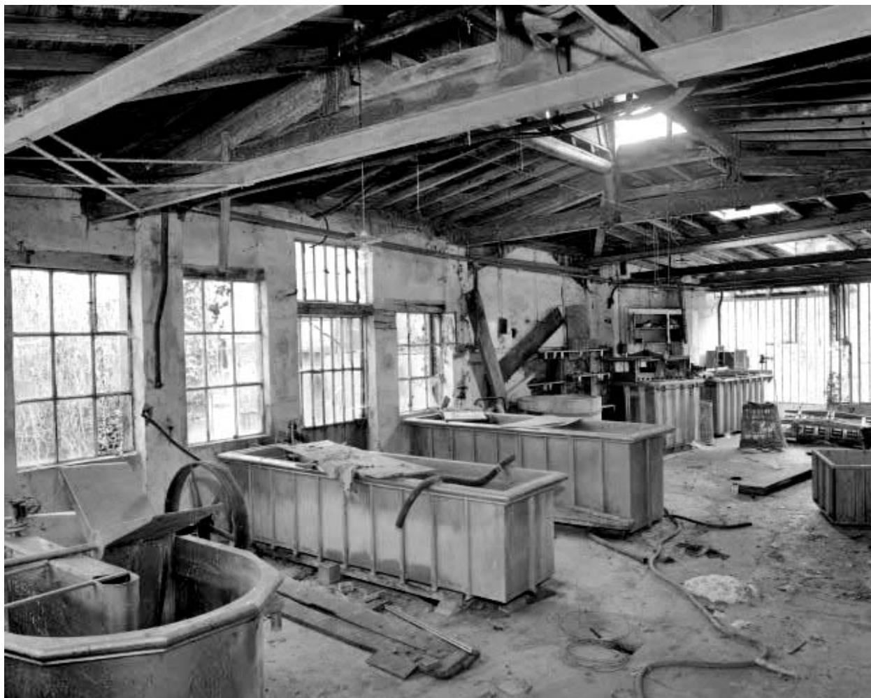
Intérieur de l'atelier de teinture (bâtiment P).
