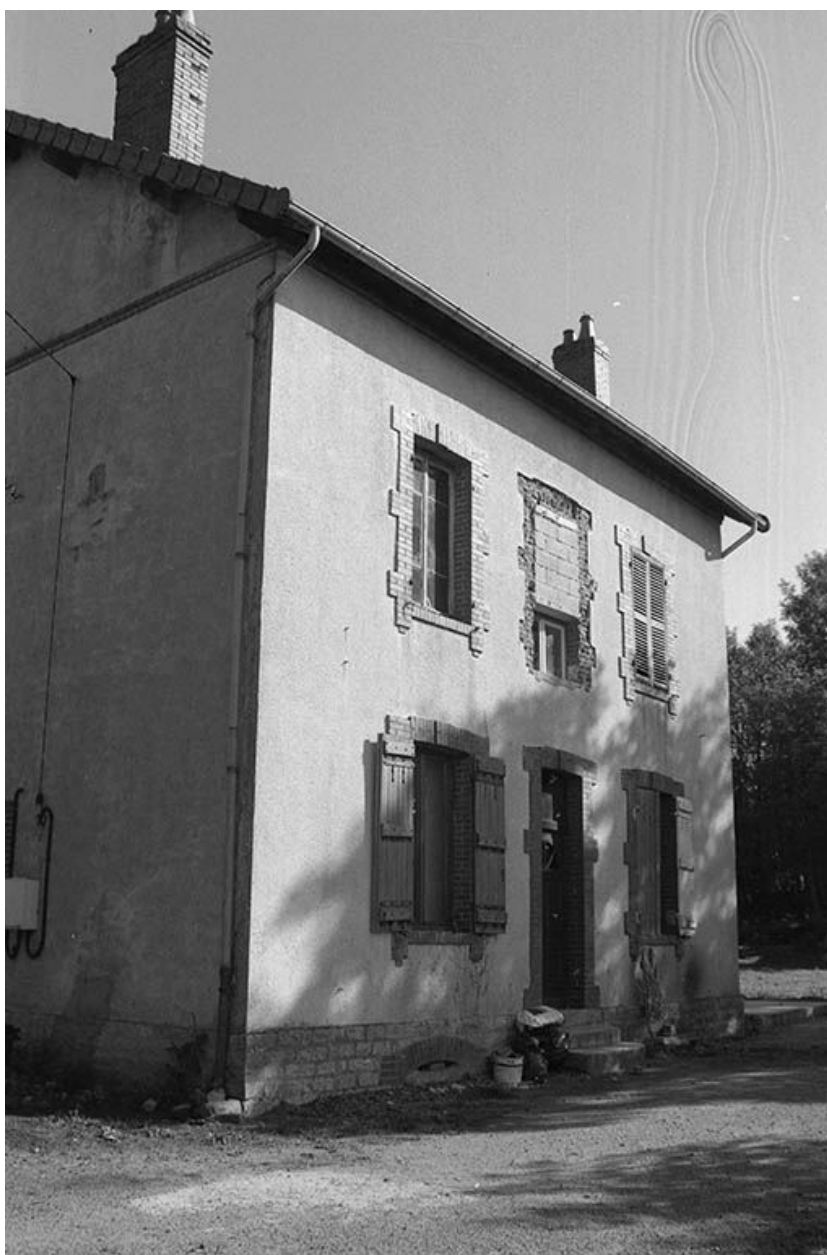
Logement d'ingénieur, vu du nord-est.
