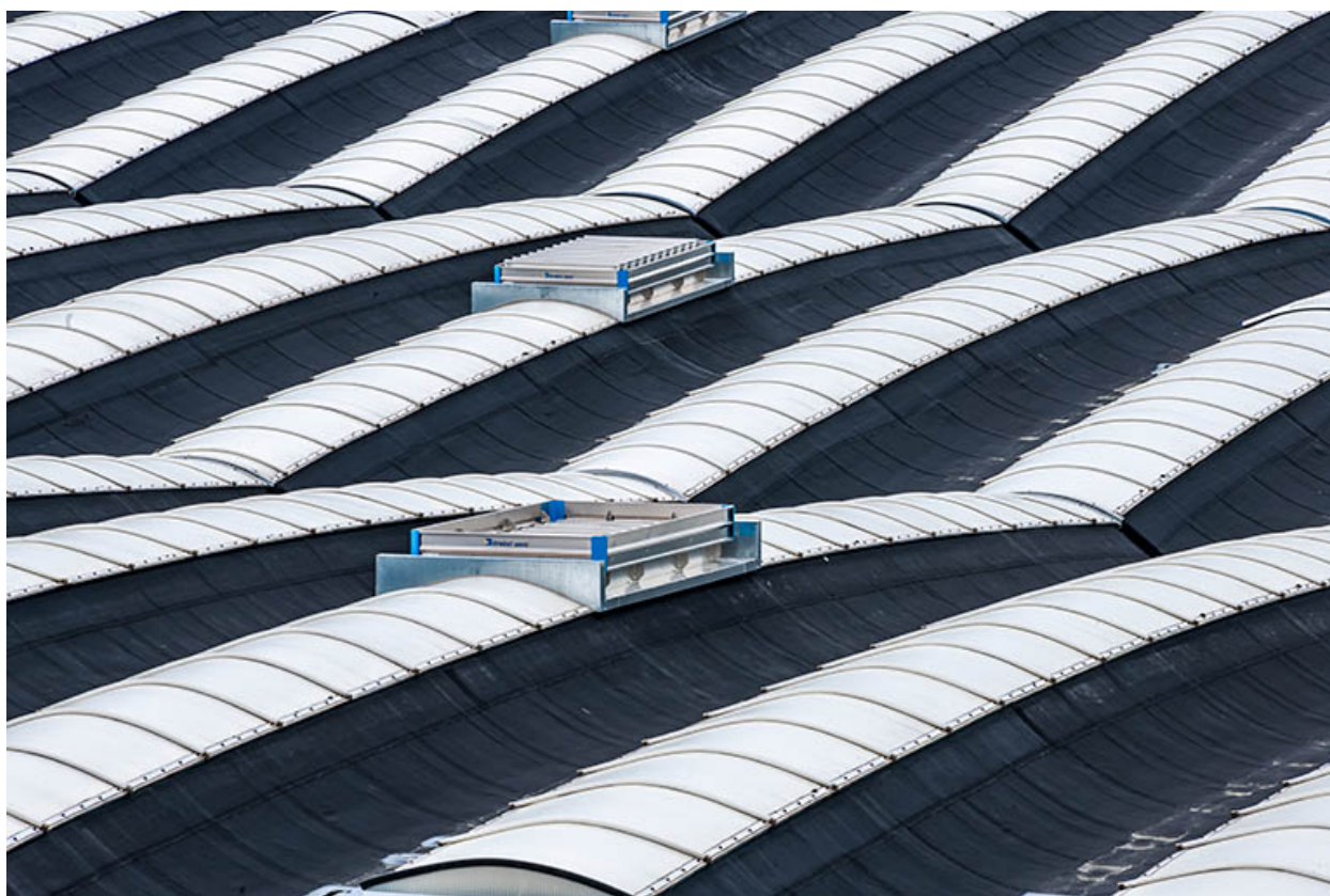
Ateliers : détail de la toiture
