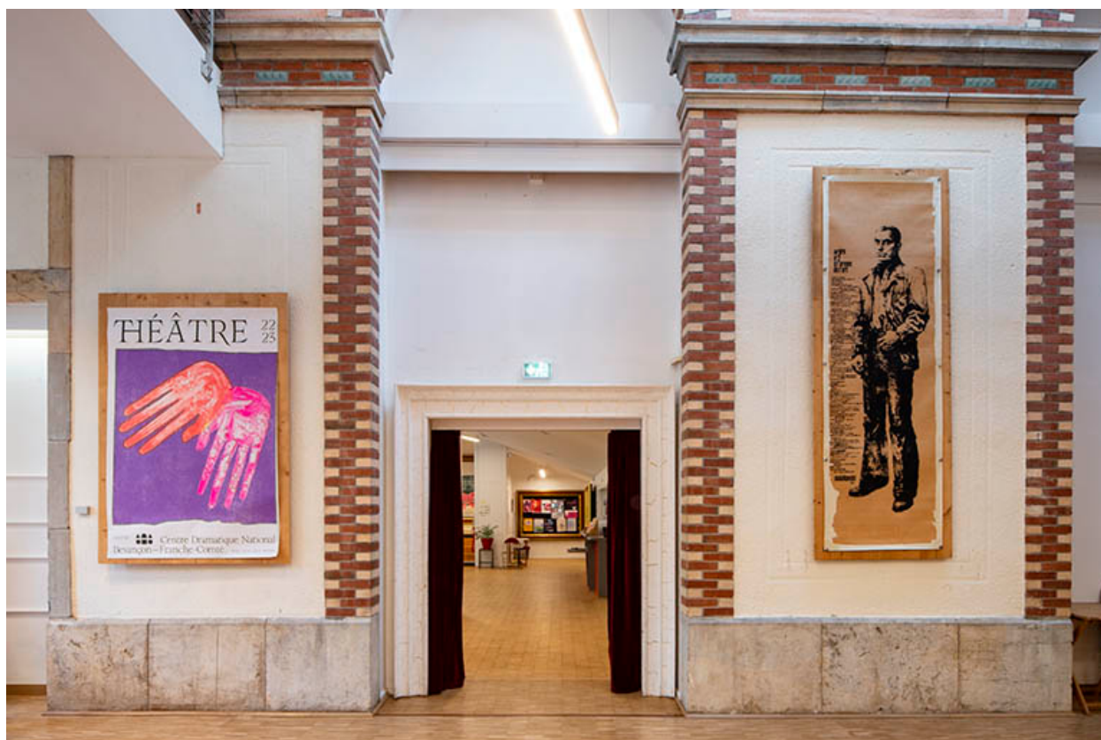
Façade latérale, aujourd'hui donnant dans l'extension de 1993.
