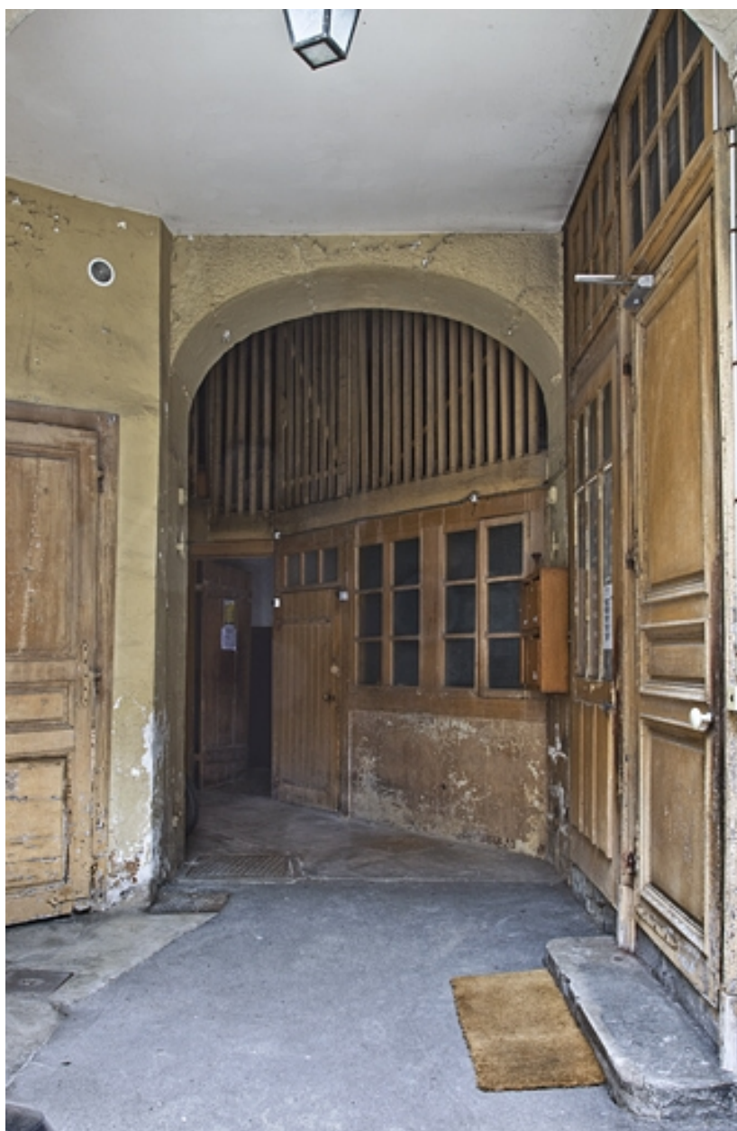
Vue d'ensemble de l'entrée de l'écurie.
