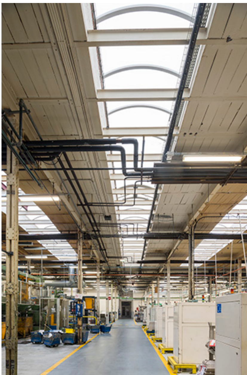
Atelier principal. Eclairage zénithal par travées.
