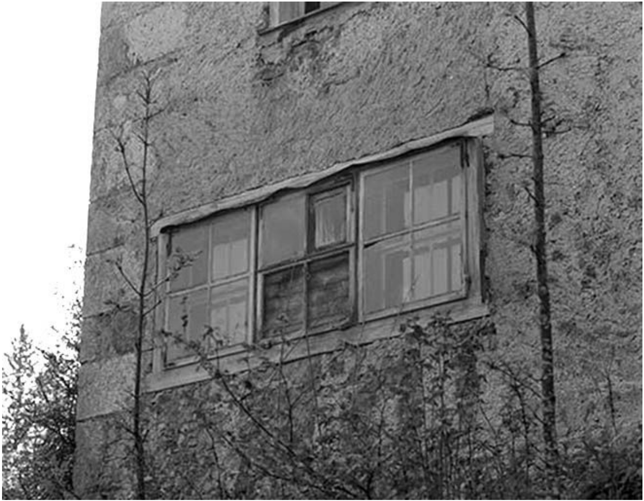
Fenêtre triple sur la façade postérieure.
