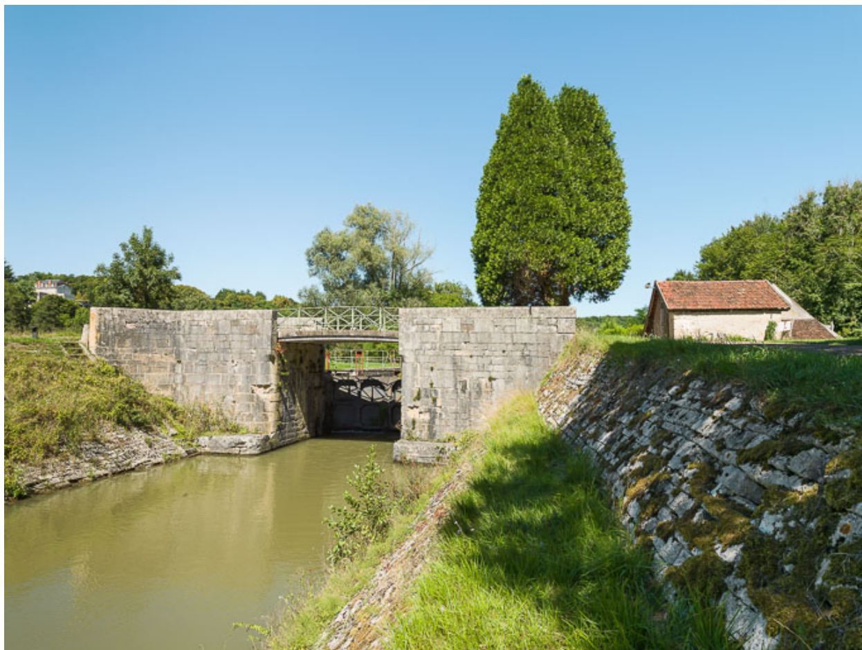
Vue d'ensemble du pont.
