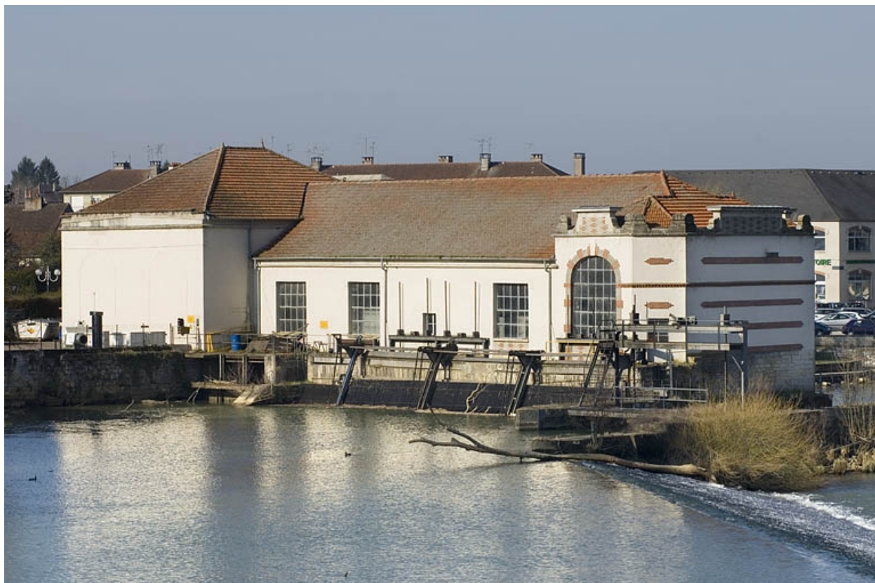
La centrale hydroélectrique vue de trois quarts.
