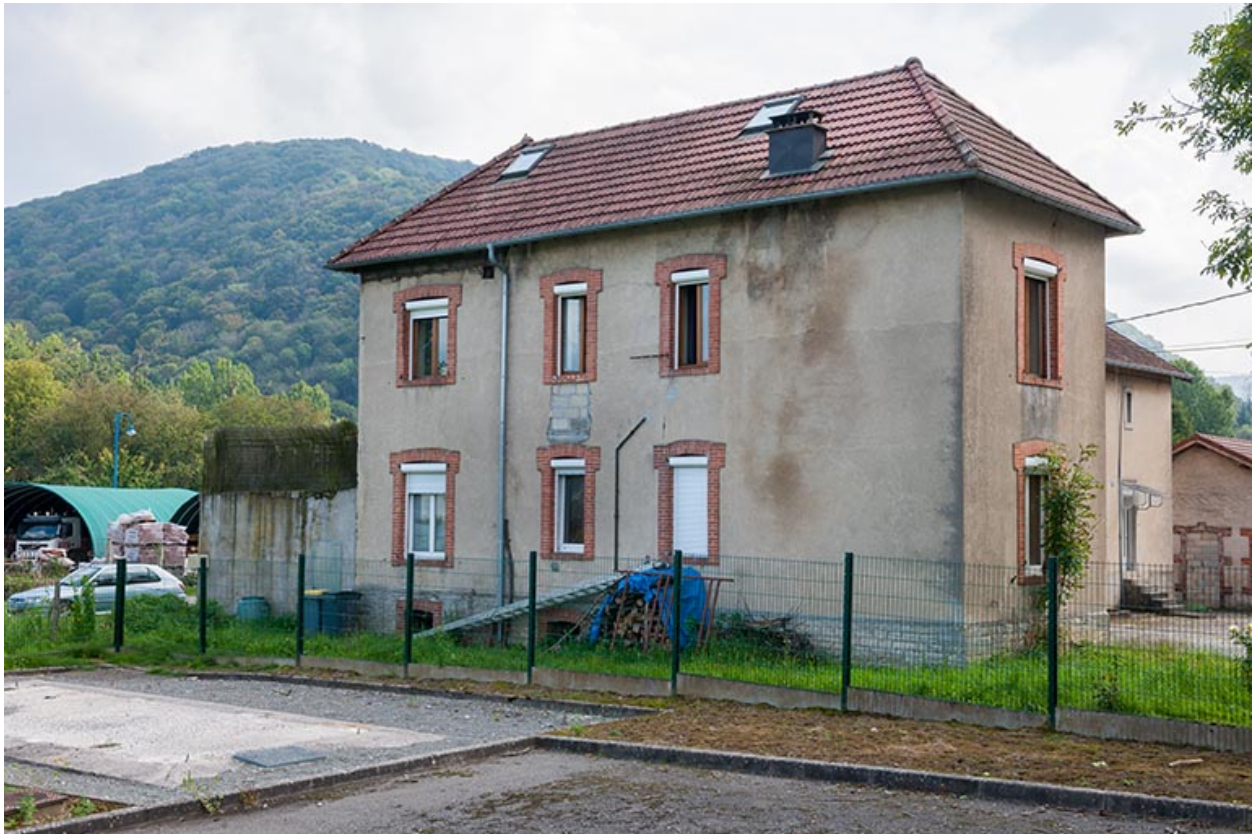
Logement ouvrier rue de Santoche. Façade postérieure.
