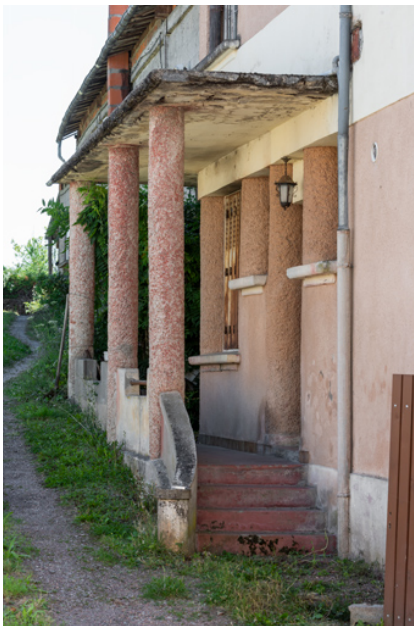
Façade latérale gauche : escalier couvert.
