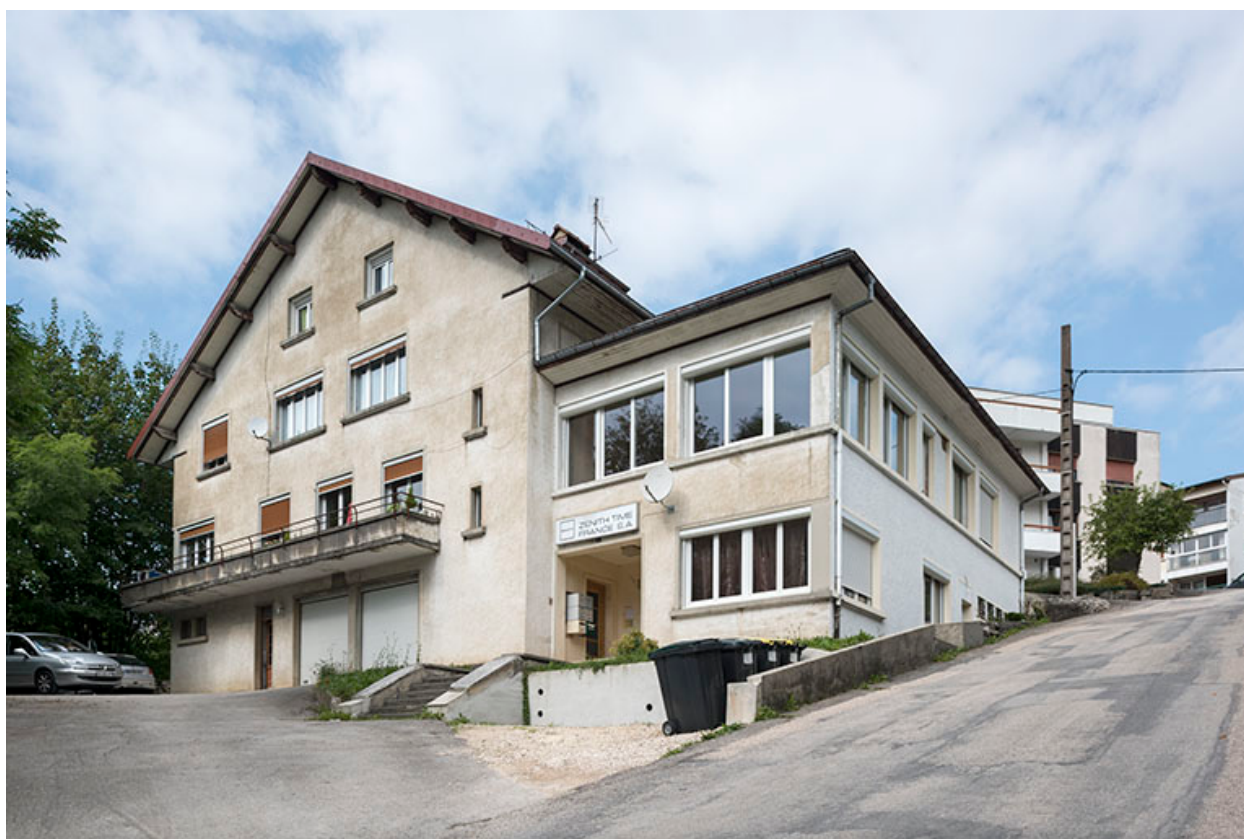
Façades antérieure et latérale droite.
