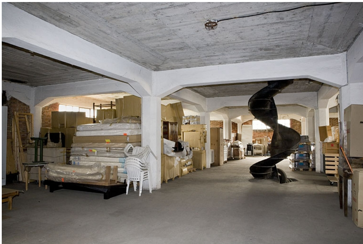
Entrepôt : intérieur du 2e étage.
