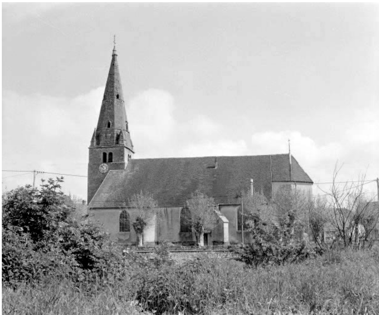
Façade latérale sud.
