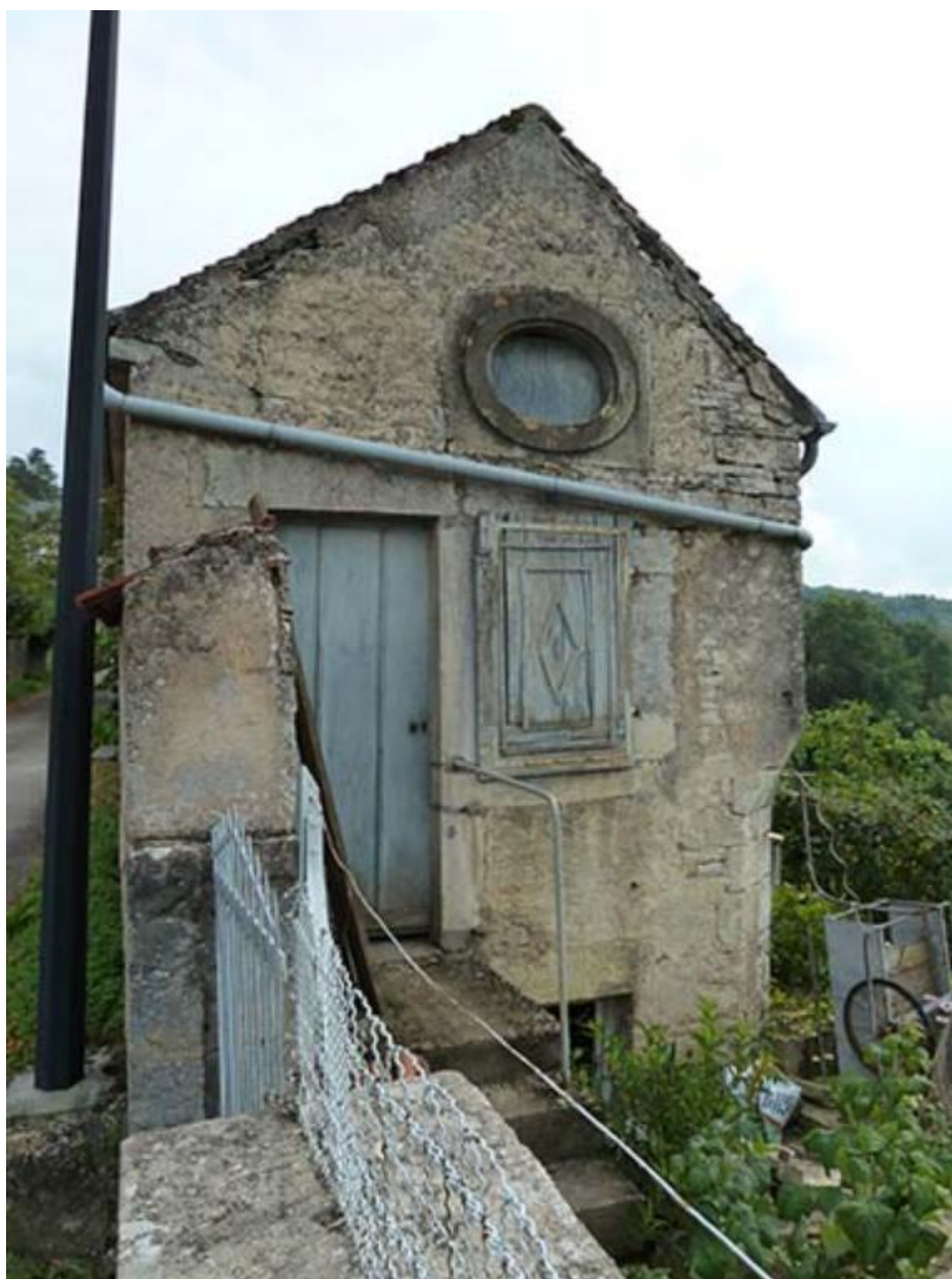
Vue générale nord
