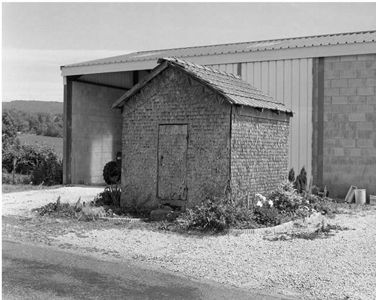
Resserre ou " grenier fort ".
