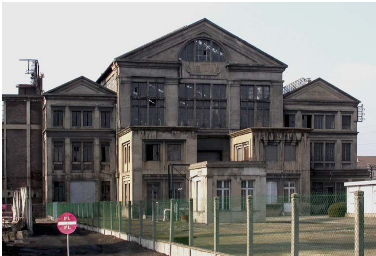
Elévation principale du bâtiments des alternateurs.
