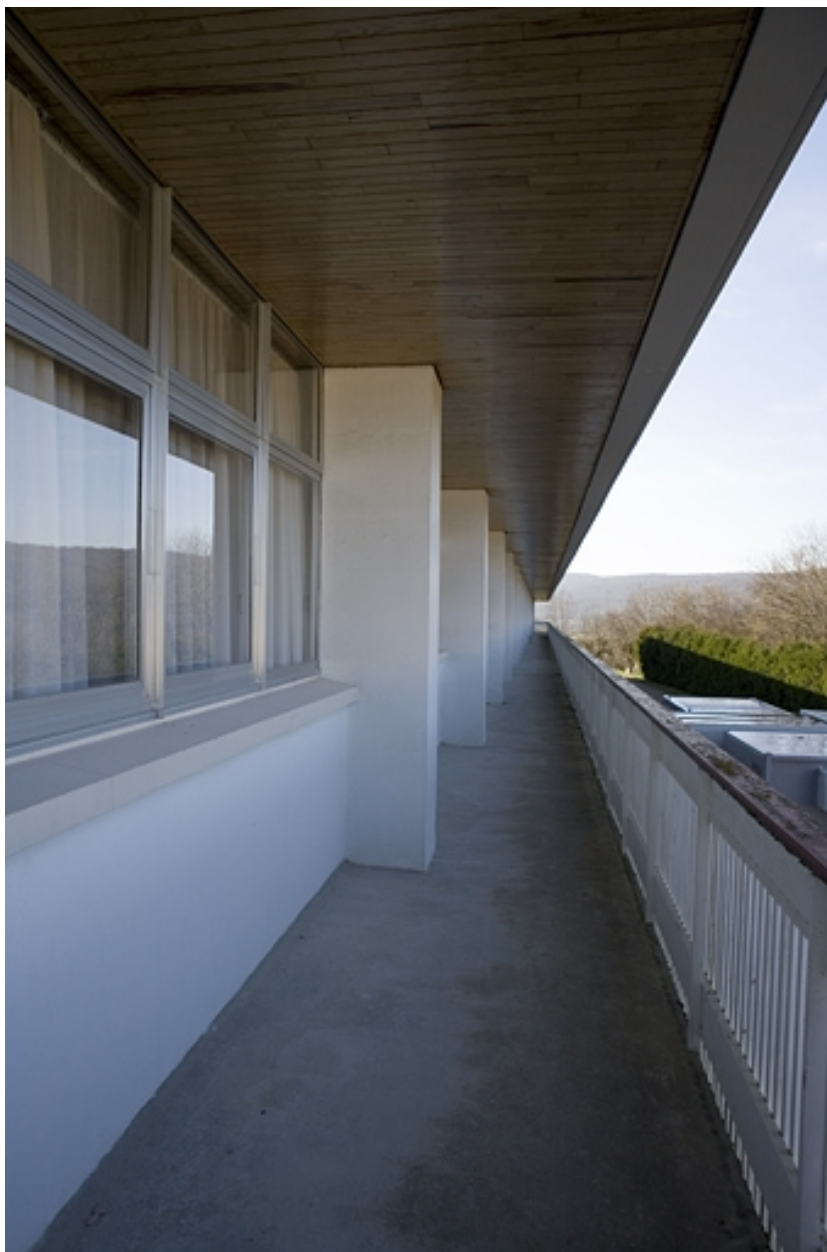
Internat : coursive extérieure à l'étage.
