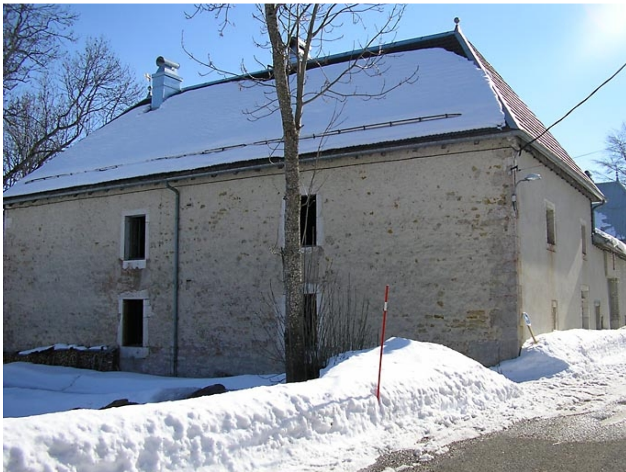
Façade latérale vue de trois quarts.
